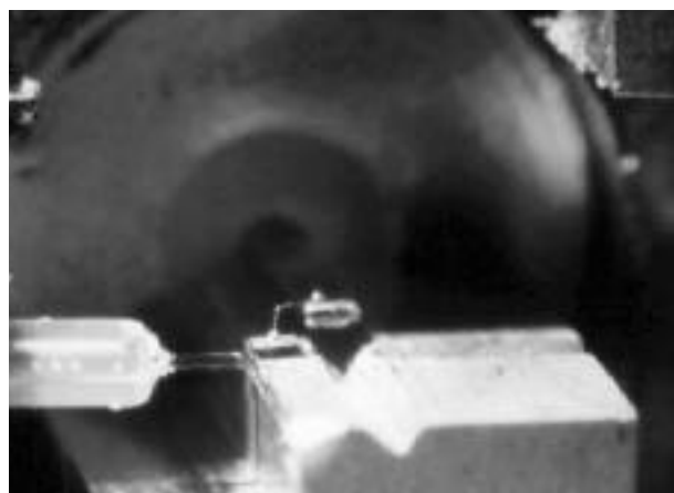
Primo laser a semiconduttori InGaAs/PlnP, emettente a 1,3 \mu m, realizzato in Italia presso i laboratori CSELT nel 1983.
