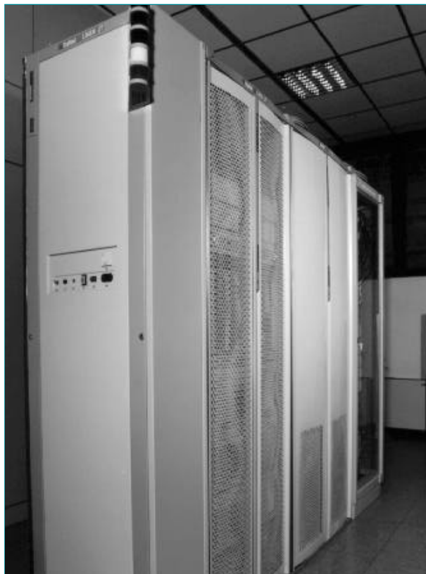
Figura 7 Sistema ATM per rete estesa dal punto di vista geografico (apparato Italtel UTXC).
