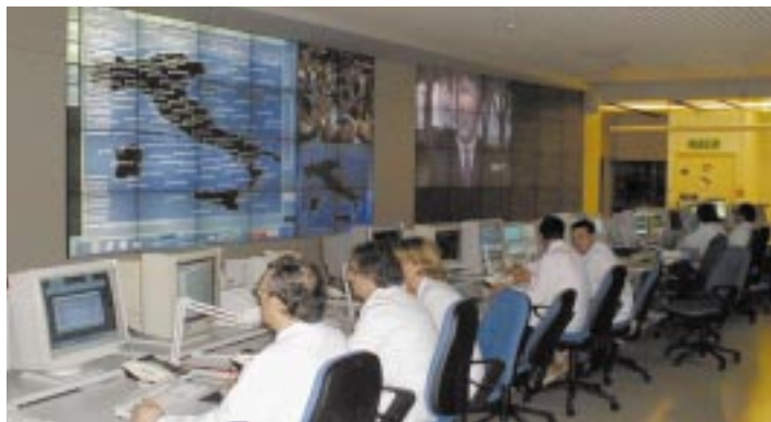
Centro Nazionale di supervisione della Rete trasmissiva a lunga distanza di Telecom Italia che trasporta anche i flussi degli operatori interconnessi.
